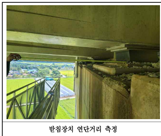
【사진 8.3.15】 교량받침장치 연단거리측정
