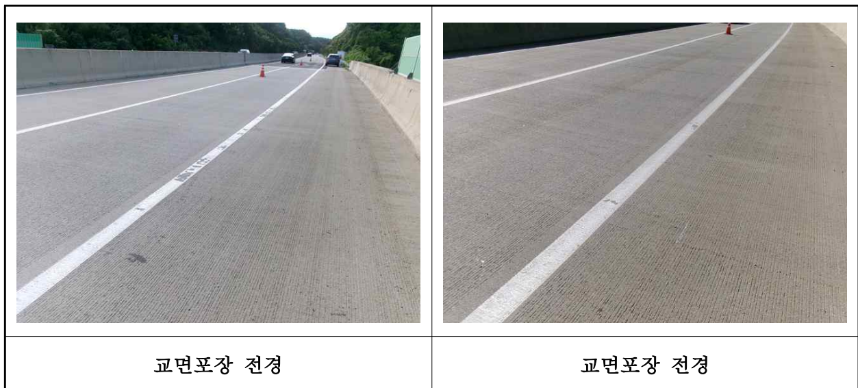
【사진 8.3.20】 교면포장 전경
