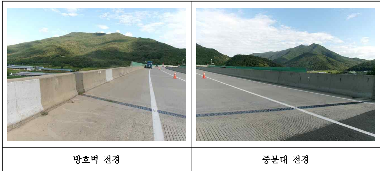
【사진 8.3.24】 방호벽 및 중앙분리대 전경
