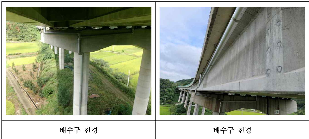
【사진 8.3.22】 배수시설 전경
