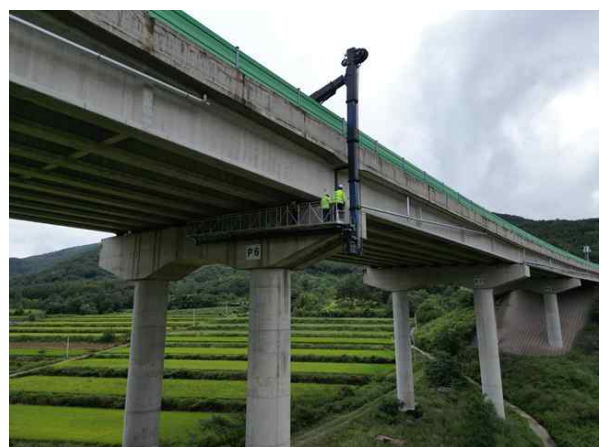
부재 현장측정 전경
