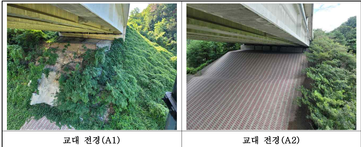
【사진 8.3.8】 교대 전경
