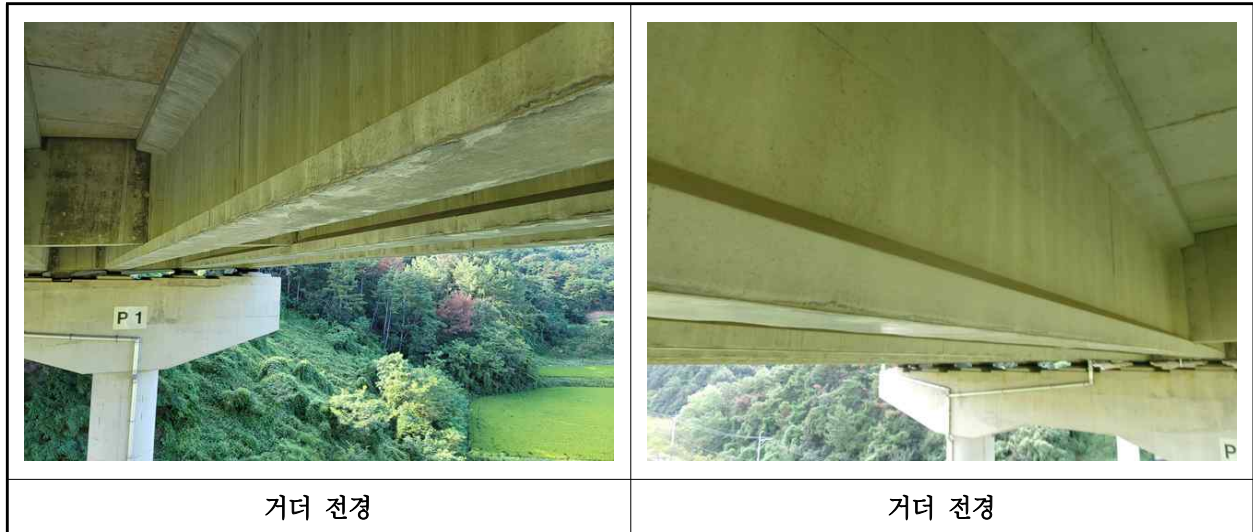
【사진 8.3.4】 거더 전경
