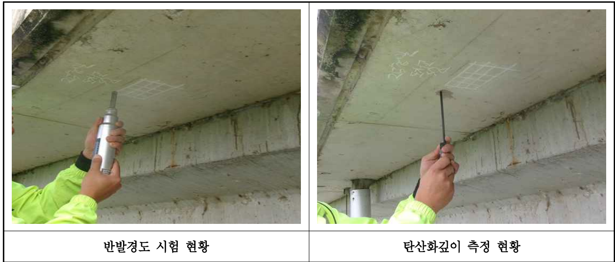
【사진 8.4.1】 콘크리트 내구성조사 현황
