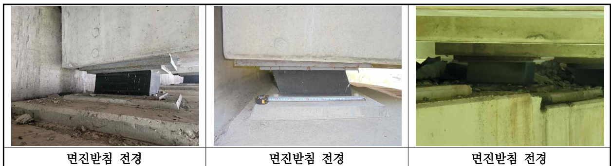
【사진 8.3.13】 교량받침 전경
