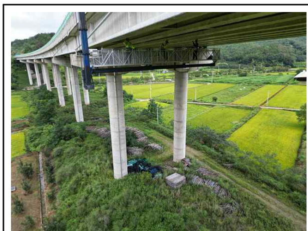
부재 현장측정 전경
