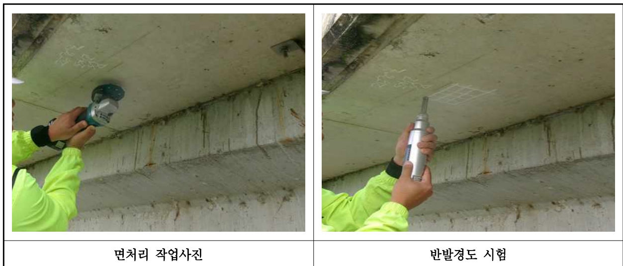
【사진 8.4.2】 반발경도시험 현장사진
