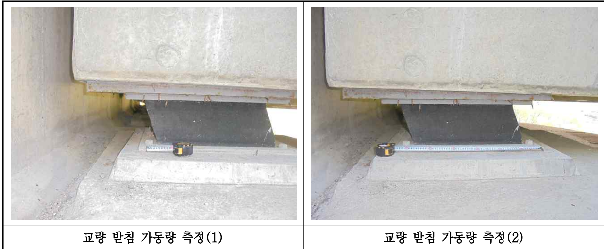
【사진 8.3.16】 교량받침 이동량 측정
