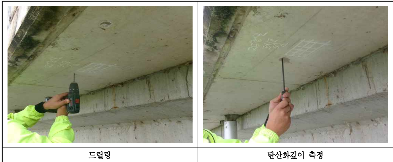
【사진 8.4.3】 탄산화 깊이 측정 현장사진
