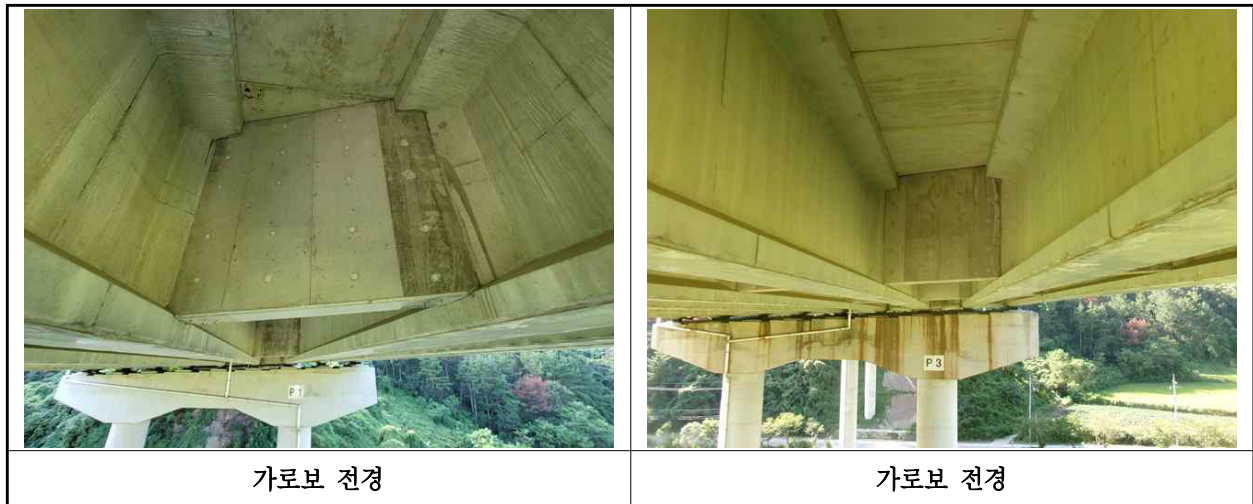
【사진 8.3.6】 가로보 전경
